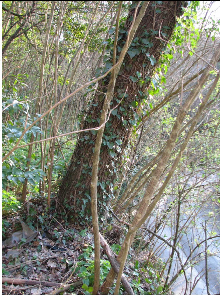
ALBERO DA ABBATERE CON DIAMETRO 50cm. PERICOLANTE E CON RADICI SUL MURO IN PIETRA DI SOSTEGNO DEL TERRAPIENO. Sponda sinistra.
